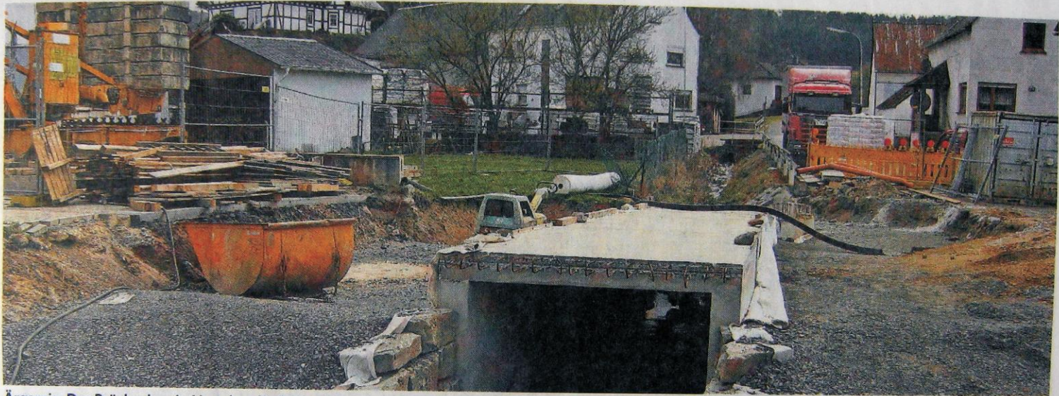
Ärgernis: Der Brückenbau in Lirstal verläuft für einige Einwohner zu langsam.
