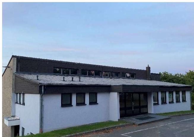
Abbildung 63: Asbestbelastetes Dach der Gemeindehalle aus dem Jahr 1983 (Quelle: Horst Gorges)
