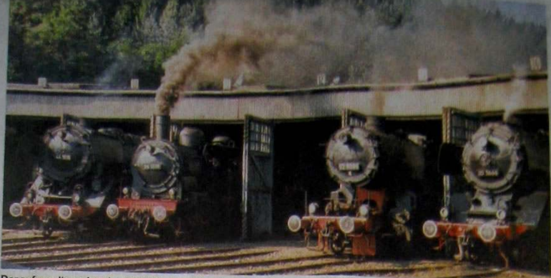
Der aufwendig und auch mit viel Steuergeld sanierte Lokschuppen hat sich binnen weniger Jahre zum kulturellen Magnet der Eifel entwickelt. FOTO: PRIVAT
