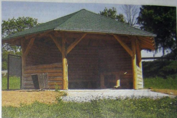
Oberelz bis nach Monreal Bauausführung gehen. Die neue Schutzhütte am Elztalradweg an der Erlebnisbrücke in Lirstal.
