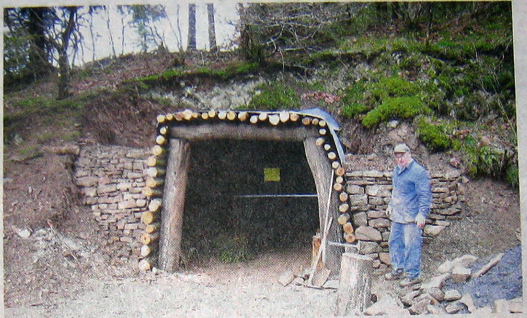
Zwischen Uersfeld und Gunderath ist Lothar Klasen momentan mit der Sanierung eines alten Schutzstollens beschäftigt. Auch dies trägt zur weiteren Attraktivierung des Angebots für die Eifel-Urlauber bei. Foto: ff
